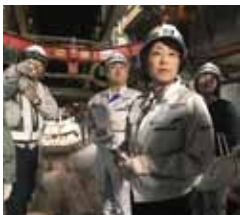
▲望月寒川トンネル工事の進捗よく状況を調査
